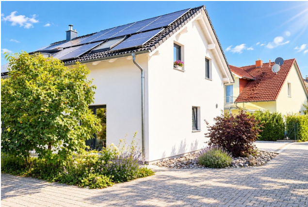
Sonniges Haus mit Solardach und Garten
