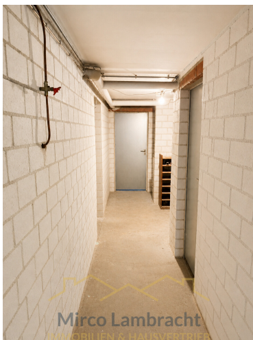
Flur im Keller
